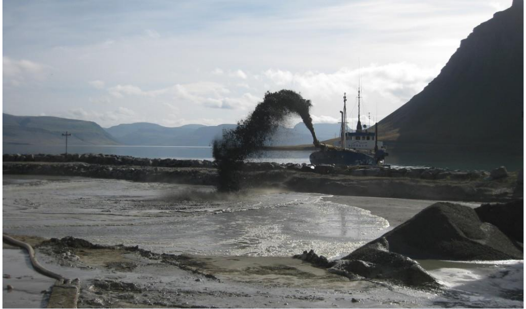
Mynd 4.4 Dæling kalkpörungasetts í hráefnislón verksmiðjunnar á Bíldudal. Mynd fengin af heimasíðu Íslenska kalkpörungafélagsins.
